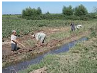
Arbeiten an einem Wasserkanal in Usbekistan. Foto: Nodir Djanibekov
